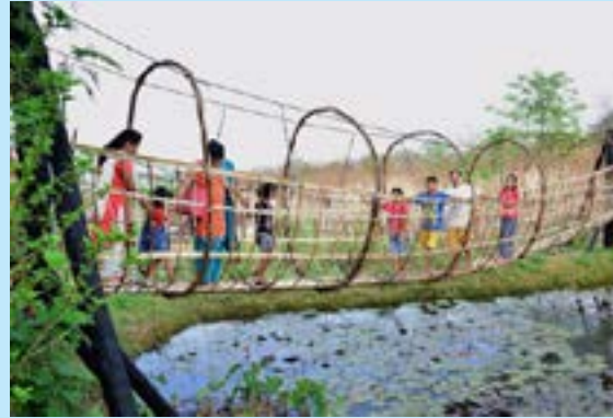
अरुणाचल प्रदेश के पारंपरिक केन और बांस पुल Traditional Cane and Bamboo bridge of Arunachal Pradesh
